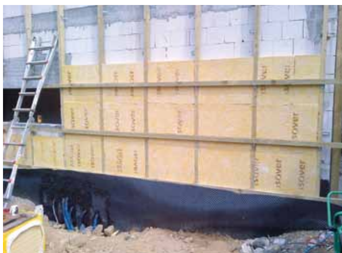
▲ Konstrukcja nośna z ociepleniem
