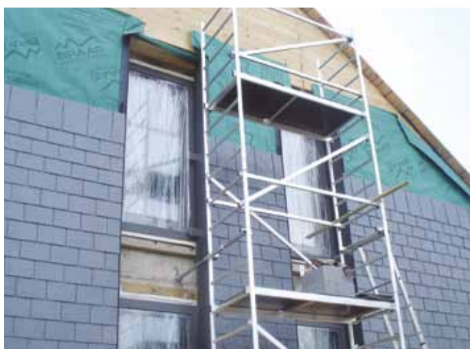
▲ Na górze widać jeszcze deskowanie niezakryte membraną, niżej już tępka okładzina
