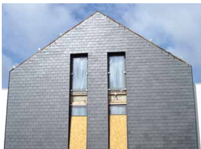
▲ Gotowa elewacja z tępki układanego na deskowaniu (wykonawca: Paweł Kwolik)
