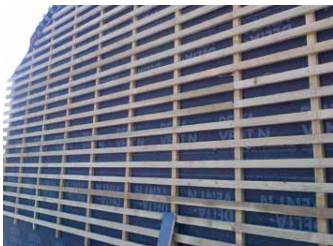
▲ Ocieplenie zakryte membraną, na której nabito ruszt z łat i kontrłat
