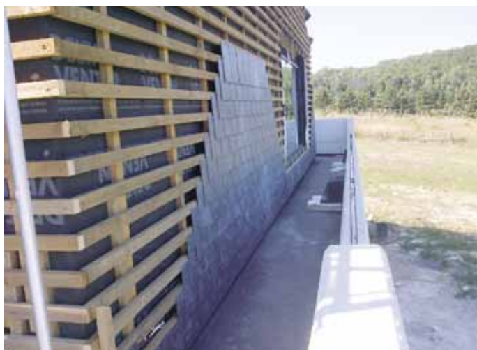
▲ Okładzina elewacyjna z kamieni łupkowych (wykonawca: Artur Alfawicki)
