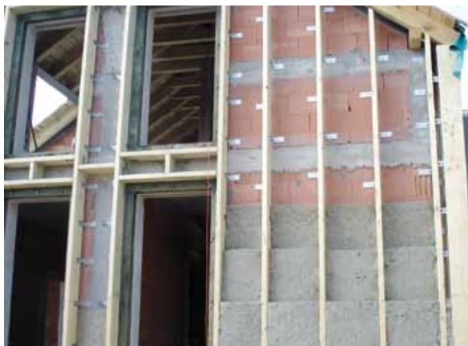
▲ Elewacja z trójwarstwowym dociepleniem z wełny
