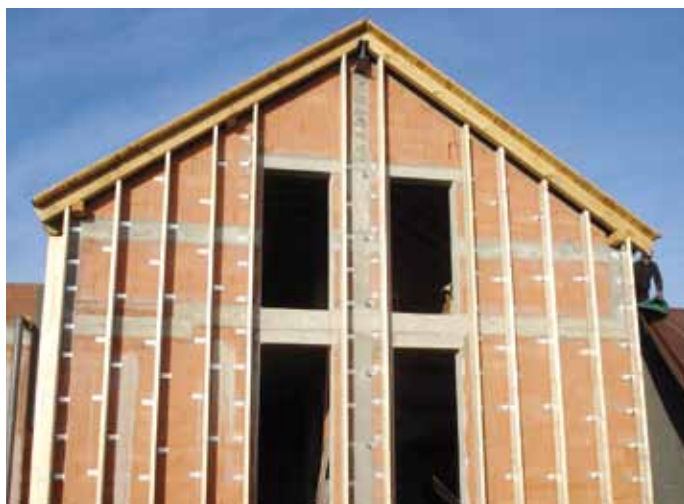
▲ Konstrukcja nośna pod tupek
