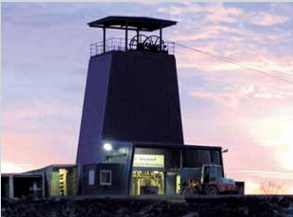
Der Förderturm des Bergwerks Katzenberg. Hier wird der kostbare Moselschiefer® abgebaut.
