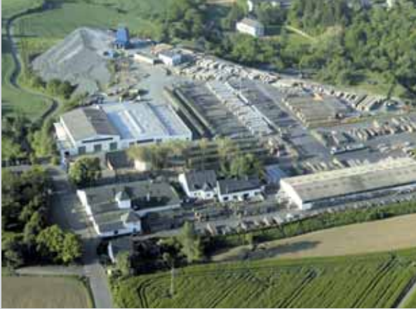
Das Rathscheck-Firmengelände in Mayen-Katzenberg.
